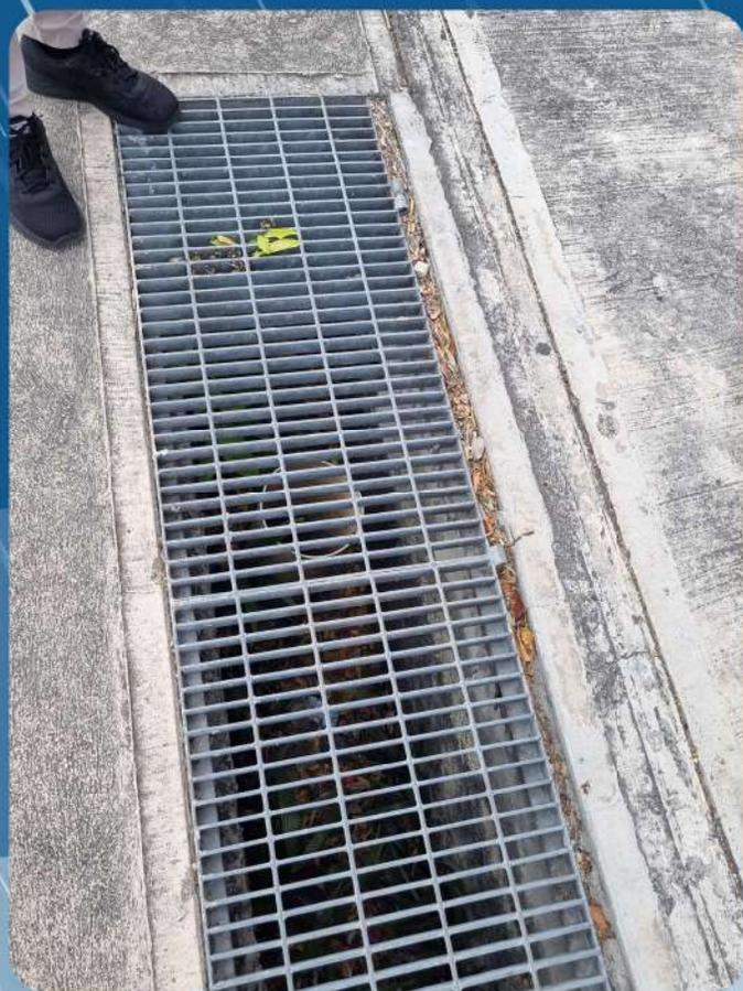
Figura 3. Zanja convencional de drenaje de agua. Fotografía: Bertha Hdz-Aguilar
